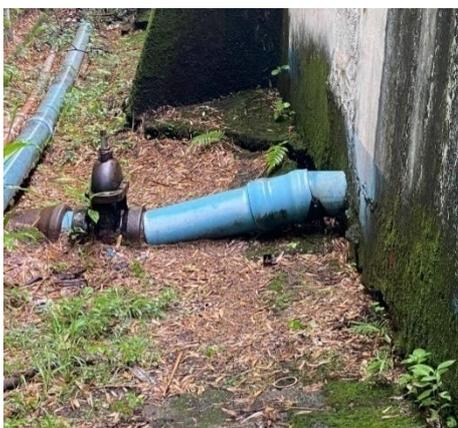
Figura 1: Imagem da lateral do reservatório, indicando o recalque e deslocamento da tubulação
