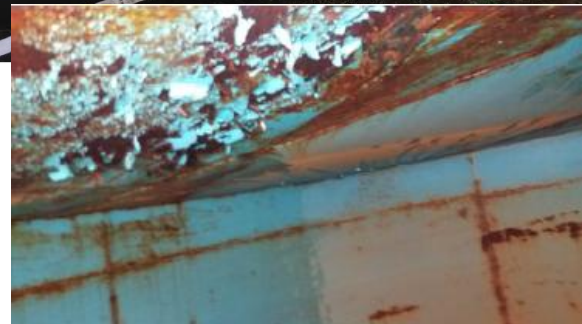
Foto 4: Vista interna, com oxidação da chapa.
